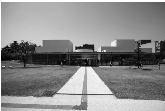
図2 東側から見た外観
